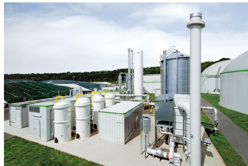
Bioloģiskā metanācija: enerģijas un gāzes process ar biomasas kurināmo (Avots: Viessmann)
