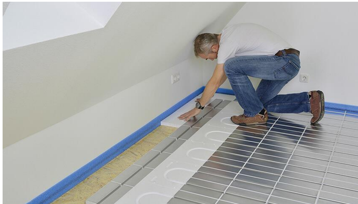
Attēls 7: Sausa konstrukcija, avots: quicktherm-fußbodenheizung.de
