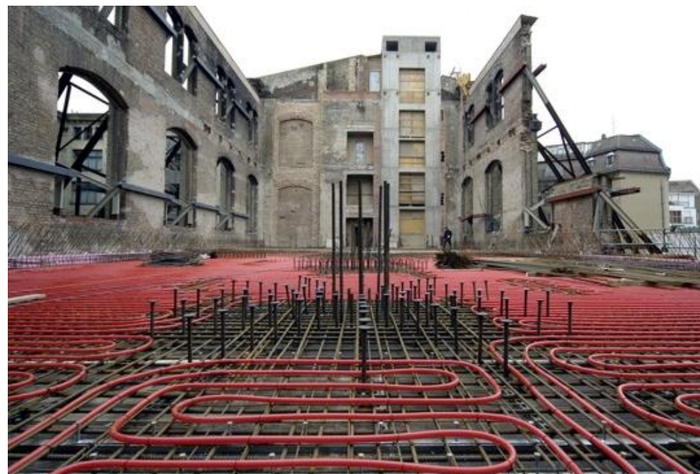
Avots 13: grīdas apsildes ierīkošana betonā (siltuma komponentu aktivizēšana), avots: beton-campus.de
