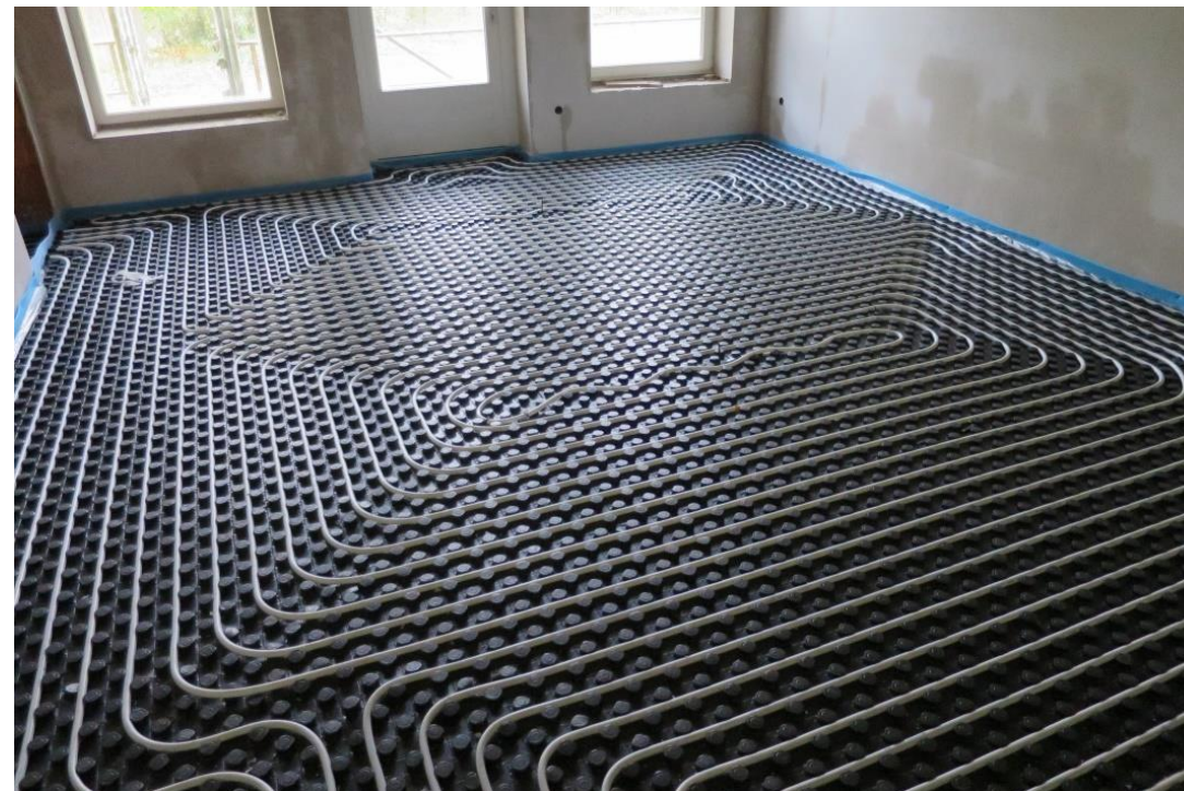
Attēls 5: Grīdas apsildes paklāji ar caurulēm, avots: © ZEBAU GmbH
