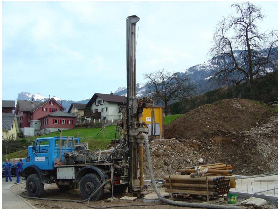
6. attēls: Zemes vertikālās zondes – urbšana un ierīkošana. Avots: sites.google.com
