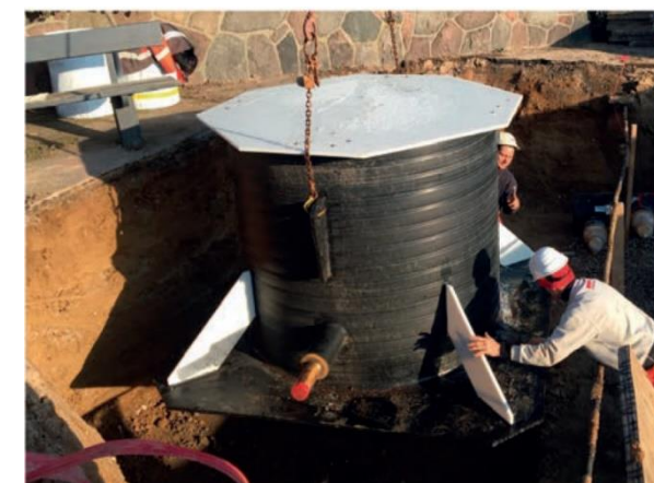
16. attēls: Zemas temperatūras zonas pilotprojekts Kopenhāgenā. Avots: Grundfos [13]
